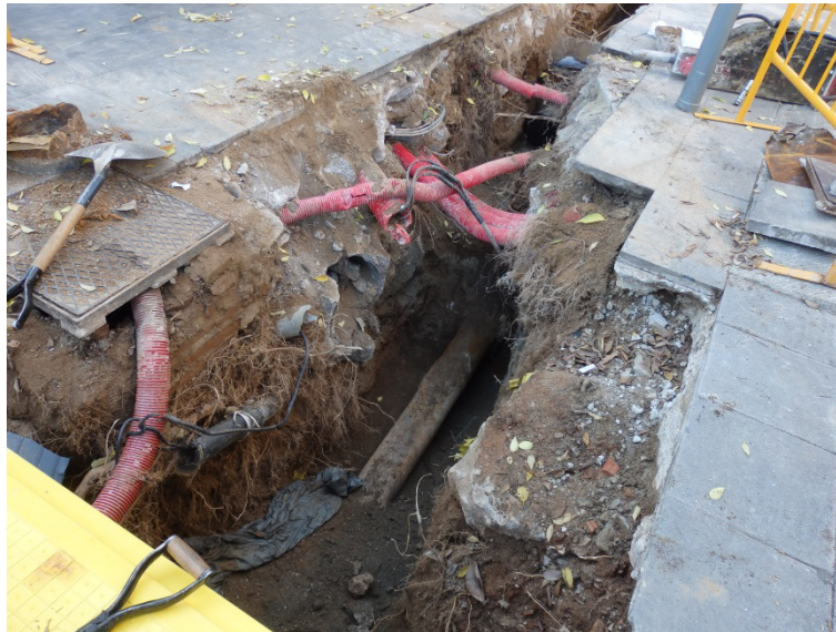
Vista de d'un tram de la rasa realitzada a l'Avinguda de Madrid
