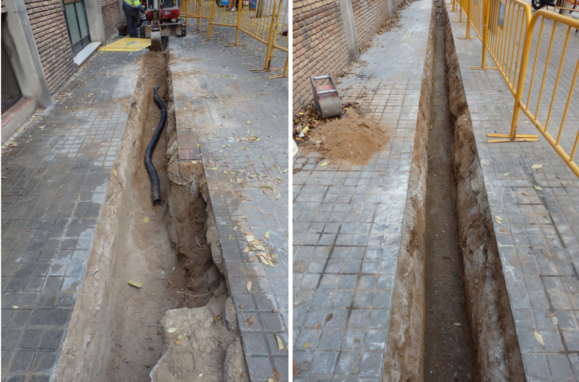
Vista de dos trams de la rasa realitzada a l'Avinguda de Madrid
