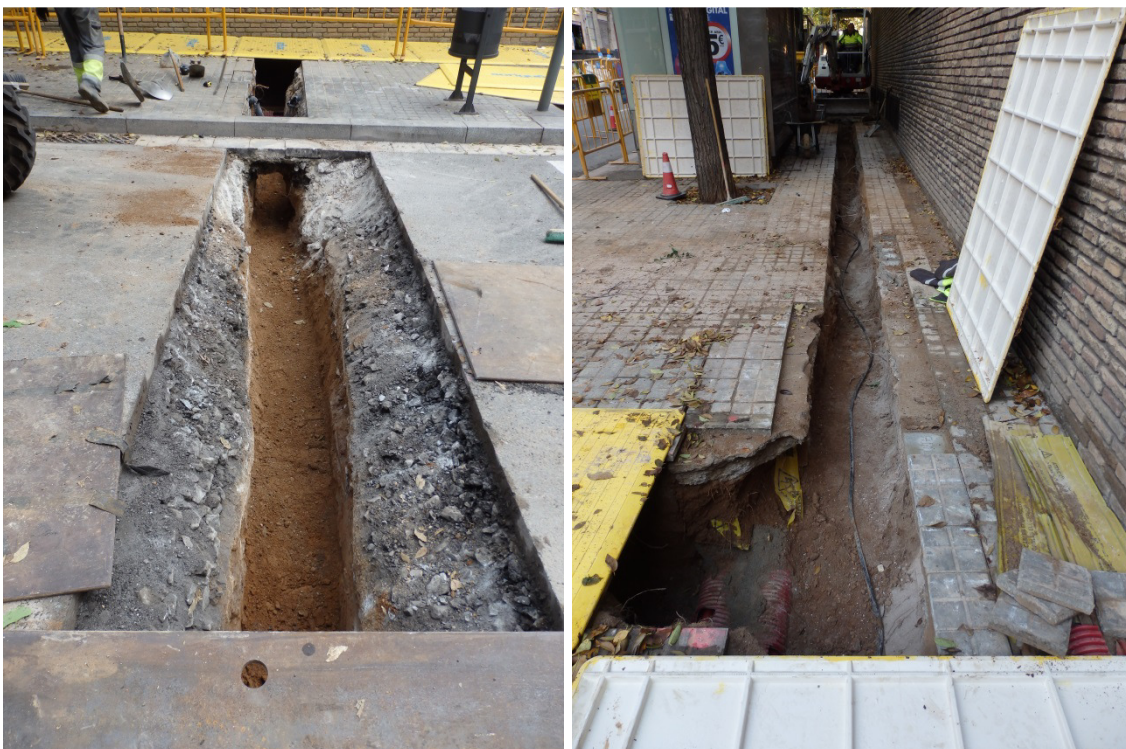
Vista de dos trams de la rasa realitzada al carrer Comandant Benítez
