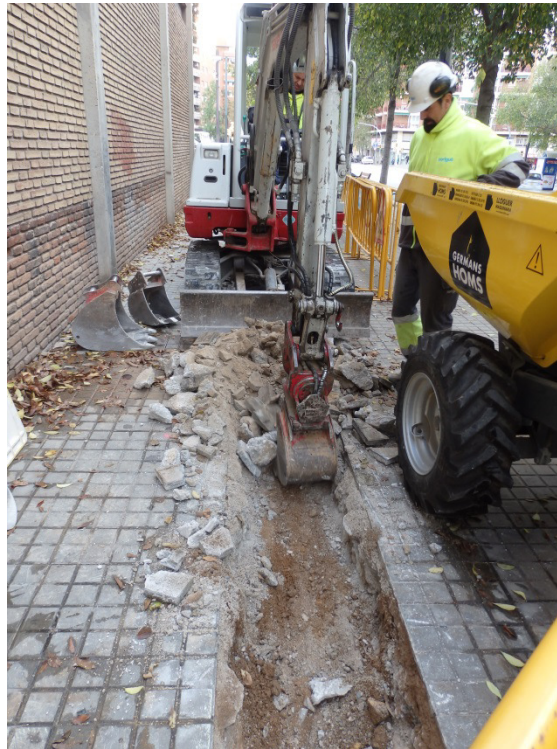
Vista dels rebaixos de terra a l'Avinguda de Madrid
