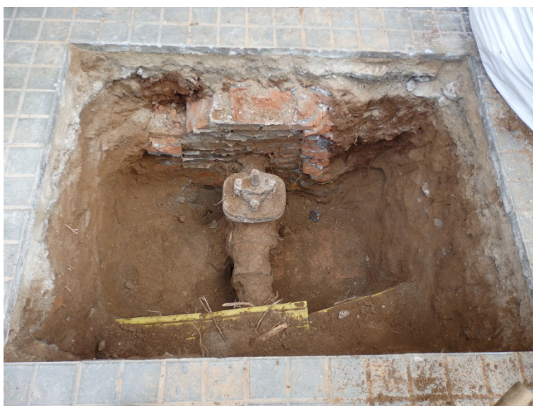
Vista del sondeig per localitzar i anular una vàlvula al carrer Comandant Benítez
