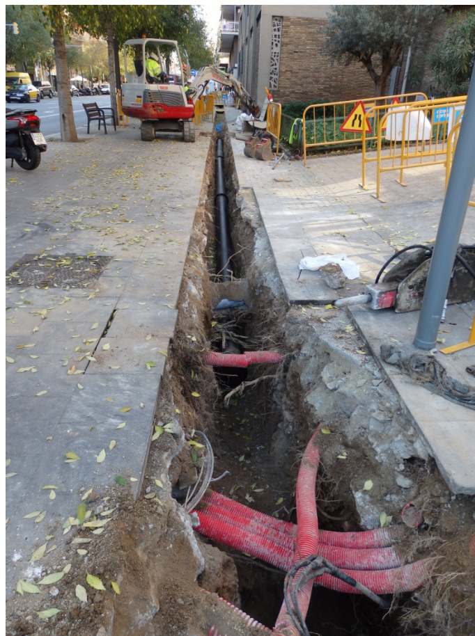
Vista de d'un tram de la rasa realitzada a l'Avinguda de Madrid
