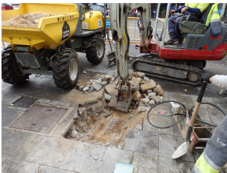
Vista de la demolició del paviment a l'Avinguda de Madrid
