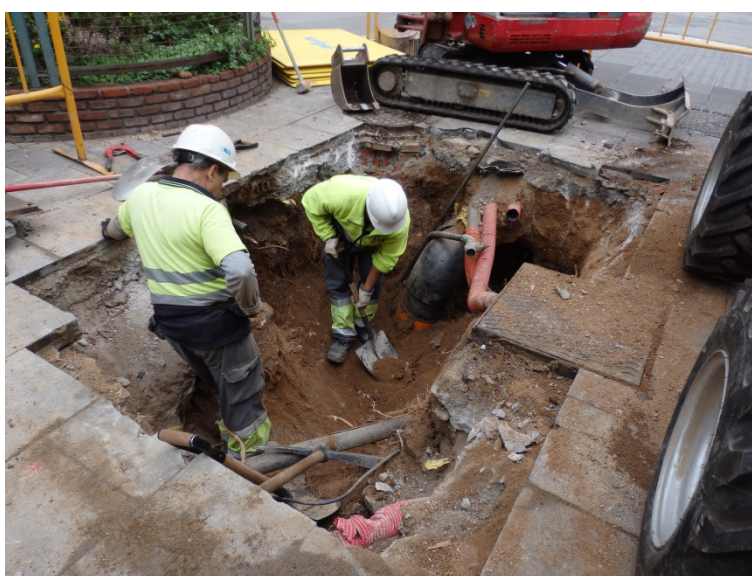
Vista dels treballs manuals dels operaris a l'Avinguda de Madrid
